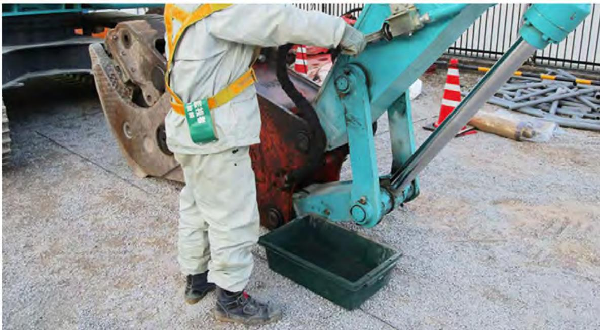
アタッチメント交換時に、油が敷地内に漏れないように油受けを設置して交換するようにしています。
