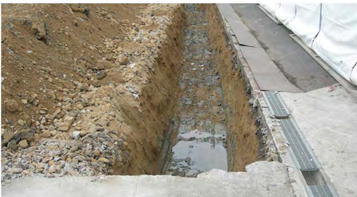
現場によって散水排水が敷地外にもれないよう、敷地内に側溝を施しています。
